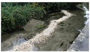
Pose du géotextile aiguilleté en fond des banquettes avant d'être recouvert par les matériaux terreux.
